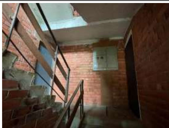
1.stāva kāpņu telpa
